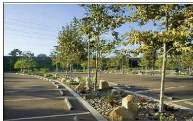
Noue centrale avec bordures basse et butée de roue
