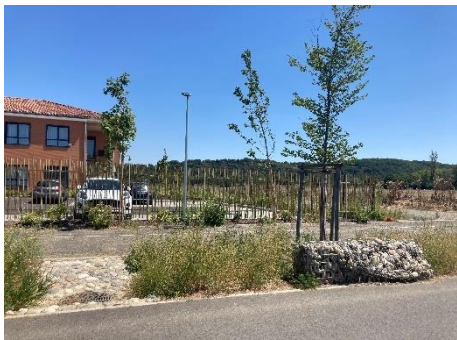
Vue depuis l'avenue du Pic du Ger sur l'EHPAD
