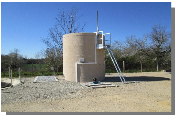
Figure 4 : Silo à boues désodorisé
