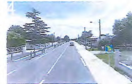
Voie verte - busage du fossé - RD 19
