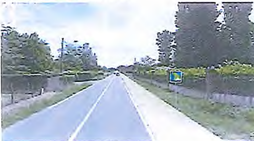
Voie verte - busage du fossé - RD 19
